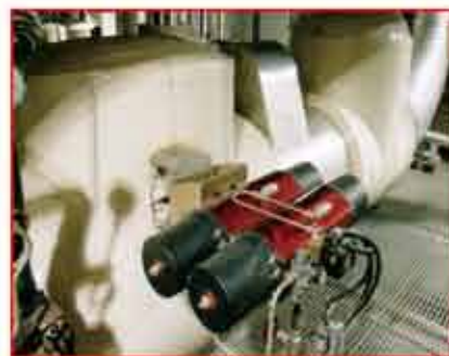
快速安全弹簧复位功能：0.5s气动快速安全切断阀（汽轮机防止冷凝蒸汽倒流）。
